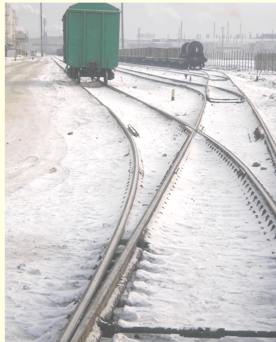
Фото № 182. После введения «Ремпутём» в эксплуатацию новых путей на станции «Трубная», появилась возможность принимать с «Промышленной» длинные поезда и формировать непосредственно на станционных путях грузовые передачи довольно большого объёма в пределах станции без особого ущерба для маневровой работы локомотивных бригад. На снимке: приемоотправочные пути №8 (вместает в себя 59 вагонов), №9 (58 вагонов), №10 (51 вагон), №11 (50 вагонов). В данном случае – нумерация слева направо. Фотография сделана в январе 2008г.
