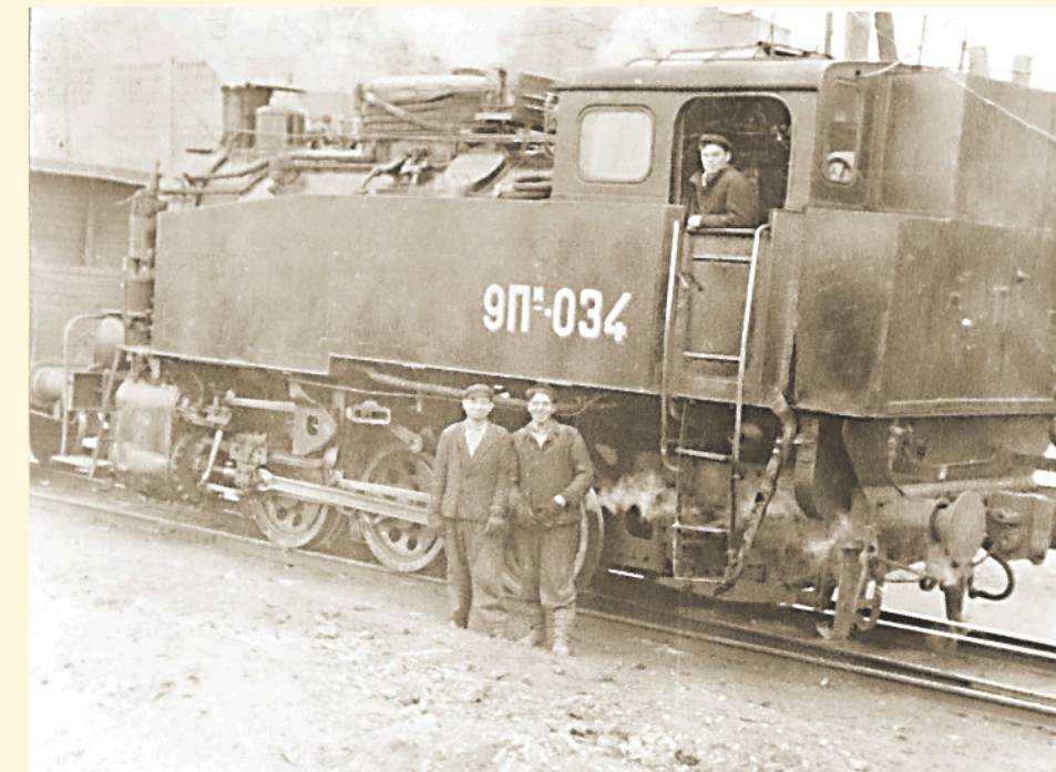
Фото № 68. До войны Муромский паровозостроительный завод им. Дзержинского только ремонтировал паровозы, однако с 1955 года вышла опытная партия паровозов «9П» с изменённой конструкцией отдельных частей. Локомотивы назывались «9П» и несколько паровозов из этой серии попали на Выксунский завод. На снимке: выксунская локомотивная бригада около паровоза «9П». Фотография конца 50-ых годов.
