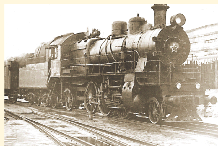
Фото №32. Паровозы «С» выпускались советской промышленностью в период с 1924 по 1942 гг. и всего было построено 2061 единица. Конструкционная скорость таких пассажирских паровозов первоначально была установлена до 110 км/ч, затем поднята до 115 км/ч, а в 1936г. – до 130 км/ч.
