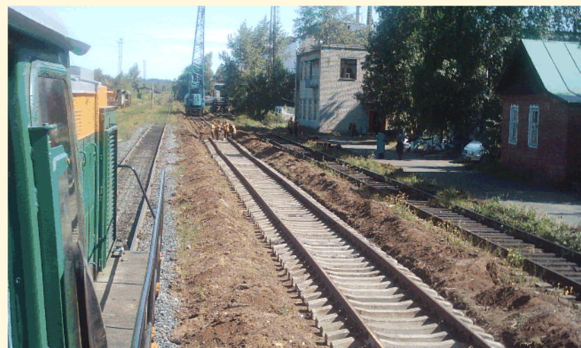
Фото №119. Укладка в путь новых звеньев силами московской строительной фирмы «Ремпуть» на станции «Выкса-Нижняя». Июнь 2005г.
