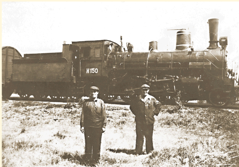
Фото №16. Первый пассажирский паровоз серии «Н» на железных дорогах Выксы с колёсной формулой 1-3-0. Фотография сделана в конце 40-ых.
